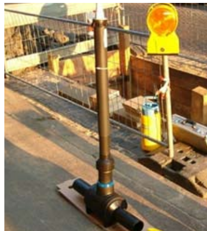
Рис. 7. Готов к монтажу: полиэтиленовая запорная арматура марки FRIALOC® с телескопическим набором (приводной штангой) типа FBS.
