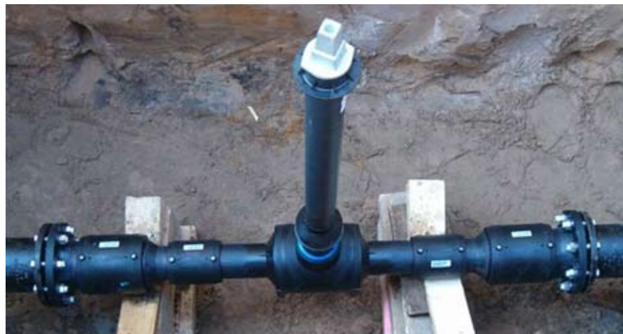
Рис. 8. Полиэтиленовая запорная арматура марки FRIALOC®, вмонтированная, посредством фланца, в чугунный трубопровод с целью подтверждения её пригодности к применению в смешанных трубопроводных системах с элементами, выполненными как из полиэтилена, так и из чугуна.
