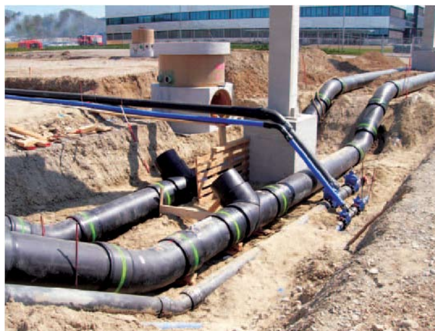
Рис. 2. Полиэтиленовый напорный трубопровод диаметром d 560 мм, при монтаже которого применялась технология электромуфтовой сварки.
