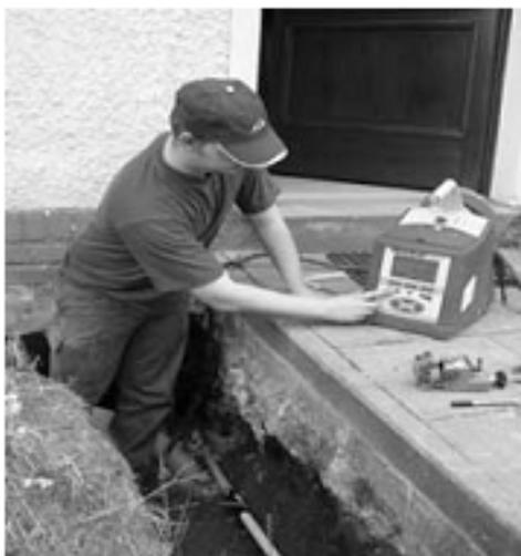
Рис. 10. Ввод данных посредством клавиш сварочного аппарата FRIAMAT.
