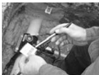
Рис. 5. Считывание штрих-кода паспорта сварщика.
