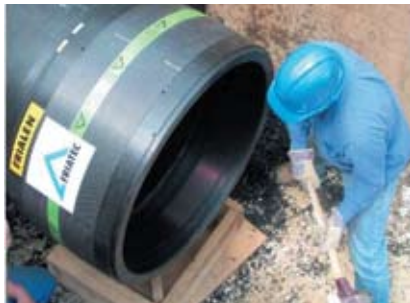
Рис. 1. Соединения с цилиндрическими муфтами требуют применения физических усилий из-за больших допусков.
