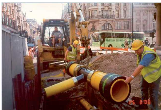
Рис. 3. Дорого! Подключение отвода к газопроводу диаметром 500 мм
