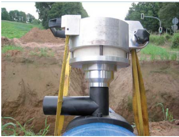
Рис. 5. Подключение частного потребителя через тройник DAA к водопроводу диаметром 400 мм для питьевой воды с механическим прижимным устройством.
